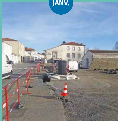
Les grands travaux du centre-bourg de Saint-Georges ont commencé !
