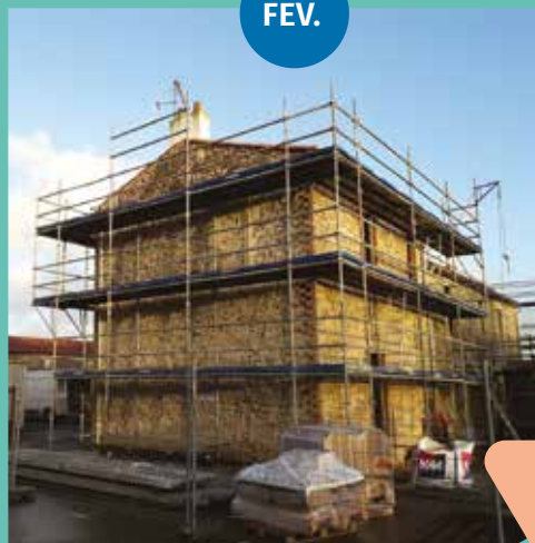
A Boufféré, le chantier de rénovation du presbytère se poursuit.
