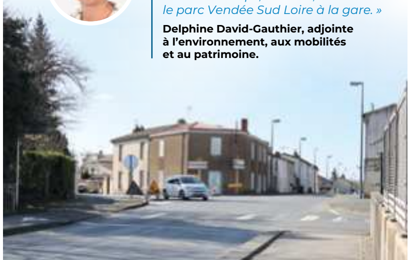
↑ Le carrefour de l'Océan avant travaux.
