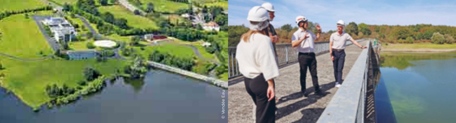
↑ L'alimentation de Montaigu-Vendée en eau potable dépend du barrage de La Bultière situé à Chavagnes-en-Paillers (photo ci-dessus) et de l'usine de Basse-Goulaine (44).
